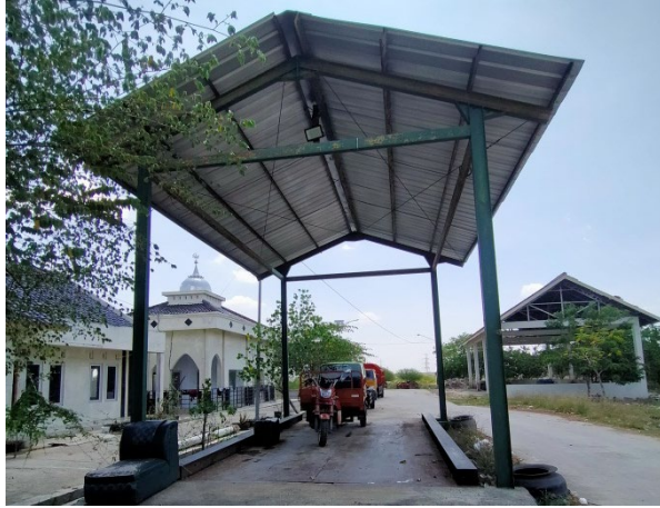
Jembatan Timbang TPA Ngembak
