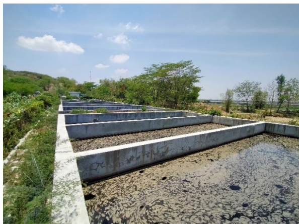
Instalasi Pengolahan Lindi TPA Ngembak
